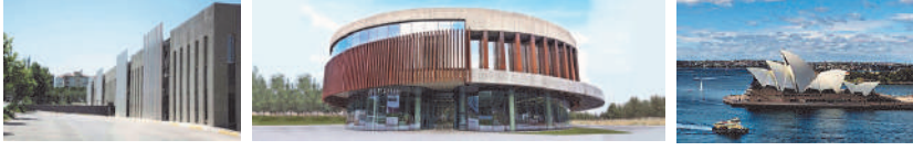
Şekil 18. (sol) Barbaros Kapalı Pazaryeri, (sağ) Uluslararası Kıbrıs Üniversitesi Öğrenci Hizmetleri Binası (orta) Düzlemsel/yüzeysel elemanlar Sydney Opera House, https://galeri3.arkitera.com/var/albums/ARKIV-06/barbaros-kapali-pazaryeri/P_2.jpg
