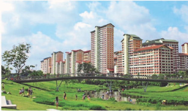
Şekil 5. Ang Mo Kio bölgesi, Singapur, (Dreizeitl Consulting,2012)
